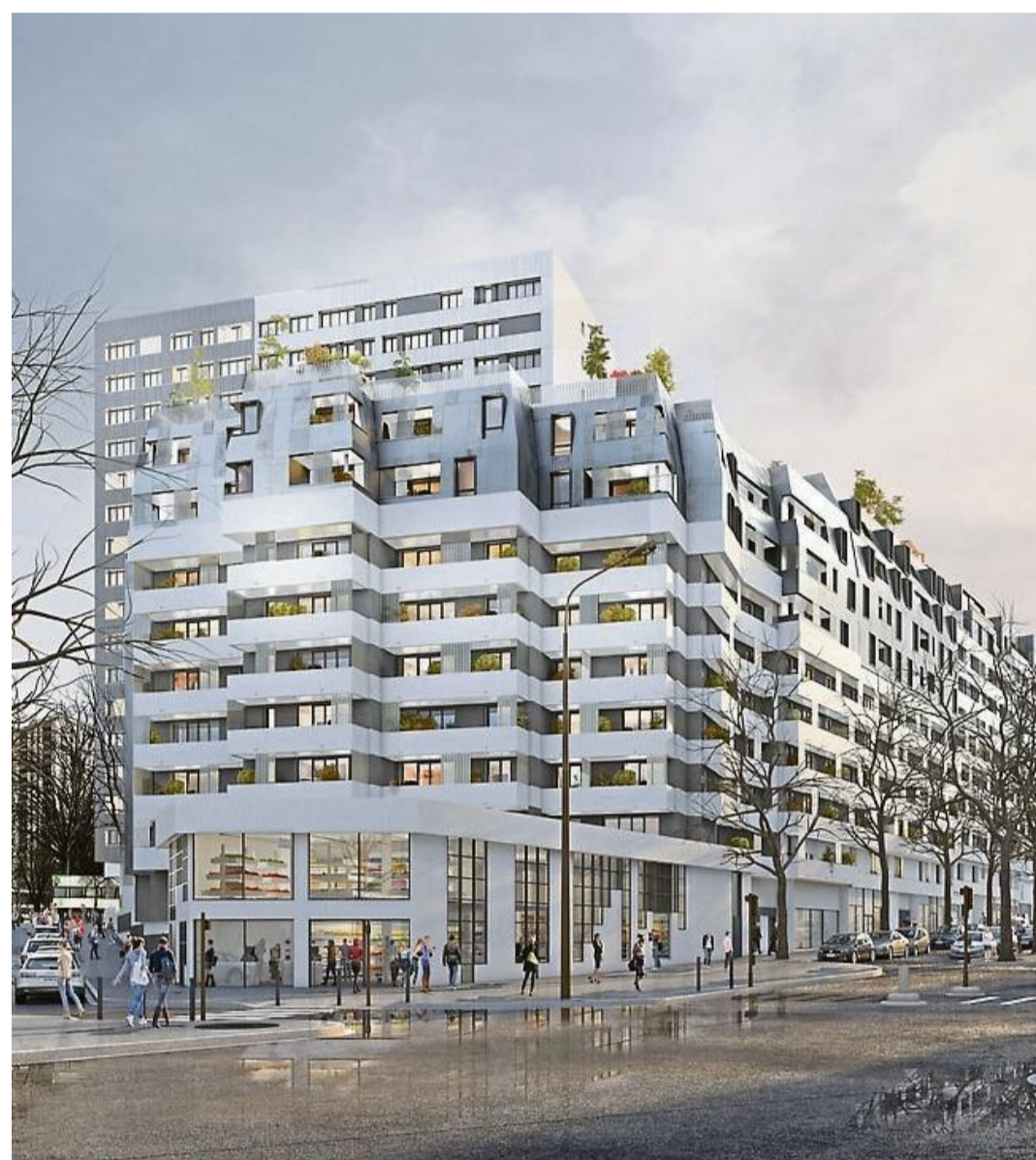
A Belleville dans l'est parisien, CDC Habitat procède à la surélévation d'un immeuble pour créer 44 nouveaux logements sociaux. Photo Groupe Arcane
